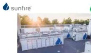
(2.6MW系统示范, 由12个225kW模组组成) Sunfire
